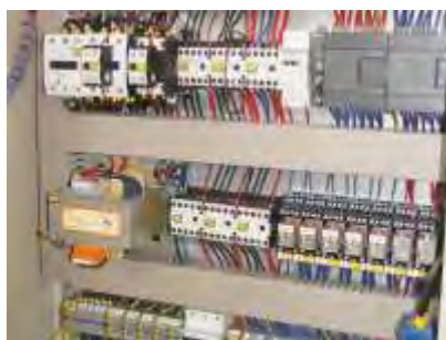
Schaltschrank / SPS-Steuerung
