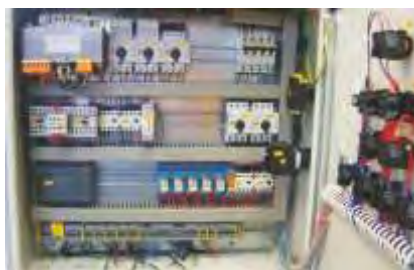
Schaltschrank / SPS-Steuerung
